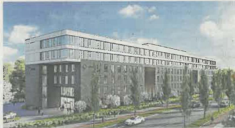
In den einen Teil dieses Neubaus soll das japanische Unternehmen Eizo im Oktober 2020 mit seiner Europazentrale einziehen. ABBILDUNG: DREIKA PLANUNGSGRUPPE
